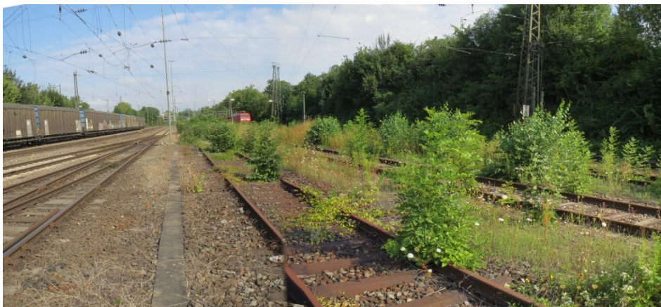
Abb. 3: Genutzte und stillgelegte Gleise im Vorhabenbereich der Interregio-Kurve
