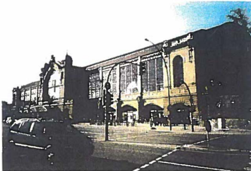
Blick auf den Dammtorbahnhof
